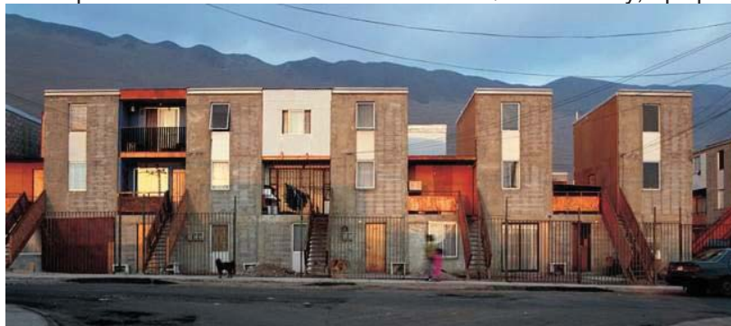
Figura 1. Expansão da estrutura inicial em 2010 - Quinta Monroy, Iquique, Chile.
